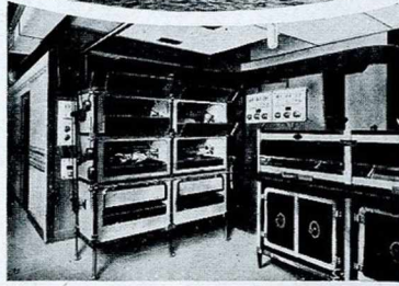
RÔTISSOIRES ET SALAMANDRES ÉLECTRIQUES INSTALLÉES SUR LE "PARIS"
